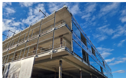
Photographie du chantier du campus condorcet, depuis le Boulevard Ney, Document autographe de octobre 2024
