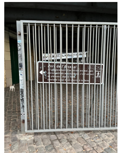
Photo de la barrière qui permet de bloquer l'accès piéton au port de l'Arsenal depuis les quais de Seine
